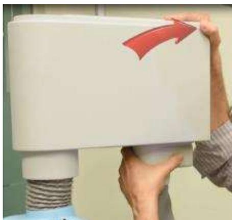
Figure 132 : Fixer l'ensemble du connecteur
